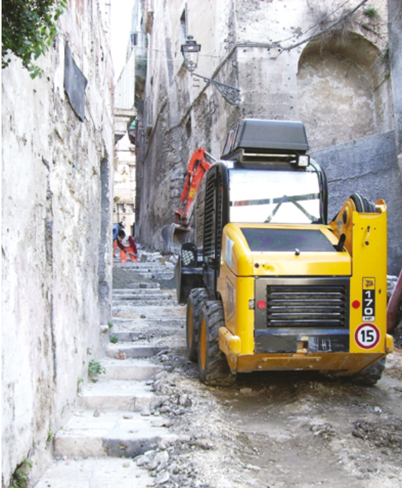
Acquedotto Pugliese. Lavori di costruzione di tronchi e derivazioni trasversali per allacciamenti di reti idriche e fognarie nell'abitato di Taranto, Città Vecchia (Postierla Nuova)
